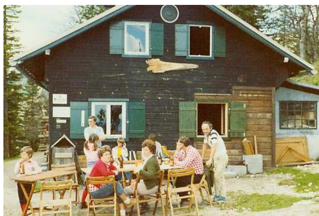
Die Göllerhütte nach dem Ersten Umbau
